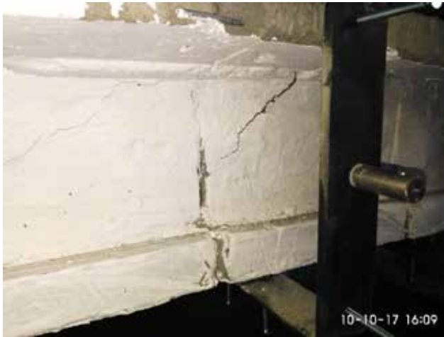
Рис. 6. Похила тріщина від вершини штучної нормальної тріщини в балці
